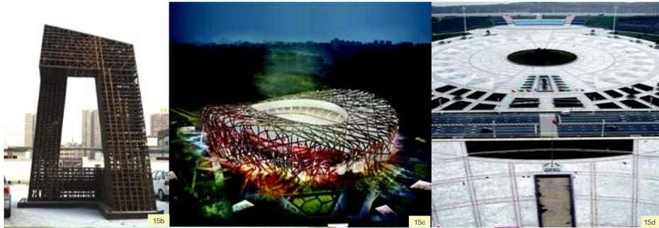
图 15b-f 钢材和水泥去了哪里？(b) 带有 70 米悬挑的 CCTV 大楼，预计将消耗每平方米 250 公斤共计 12 万吨钢材，此数量为普通办公大楼用量的 10 倍。(c) 北京 2008 体育馆“鸟巢”，预计消耗 5 万吨钢材，达到每平方米约 500 公斤，这个用量在当时被认为极其昂贵的悉尼奥林匹克体育馆的 17 倍。(d) 大广场，几乎成为现在在中国所有城市的必备元素。(e,f) 渠化工程和建坝：流经中国的河流鲜有未被截流渠化和拦河建坝的，仅一个三峡就消耗掉 1600 万立方米混凝土。(图片：俞孔坚)
